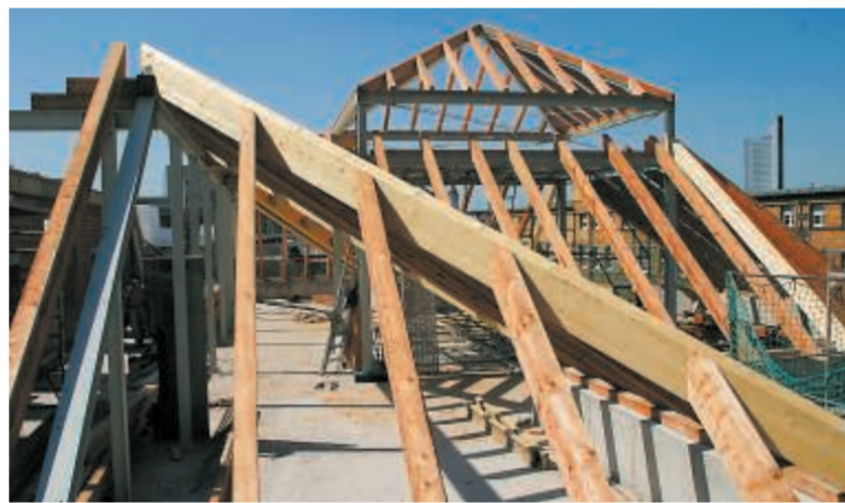
Auf dem erhalten gebliebenen Teil der Alten Chirurgie ist der neue Dachstuhl fast fertig. Hier wurde gestern der Richtkranz aufgezogen.
